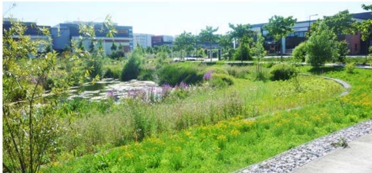
Bassin de rétention des eaux pluviales, parc d'activité des Chanteraines, Villeneuve la Garenne – © Atelier LD
