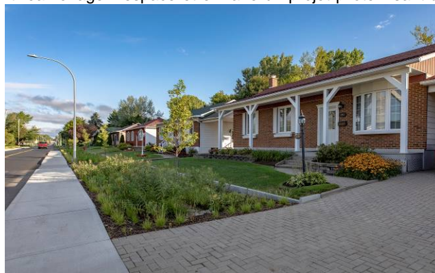
Îlot de biorétention sur la rue Saint-Maurice, Trois-Rivières © Jean-Sébastien Désilets
