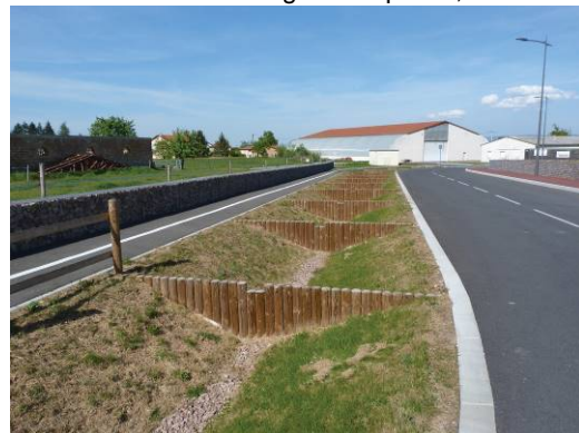
Gestion intégrée des eaux pluviales au sein d'un éco-quartier © Roannaise de l'Eau
