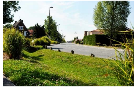
Figure 1 : Photographie d'une noue de voirie
