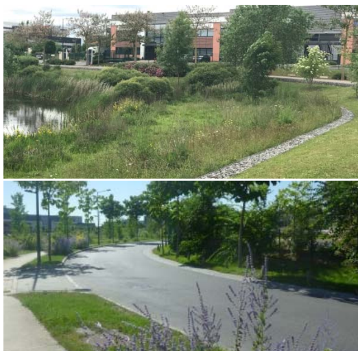
Bassin de rétention (en haut) et rue principale avec noue paysagère (en bas) / Atelier LD
