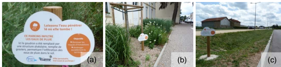
Photo 1 – (a) Panneaux pédagogiques mis en places par exemple (b) Jardin de pluie au Coteau et (c) noue enherbée à Commelle-Vernay
