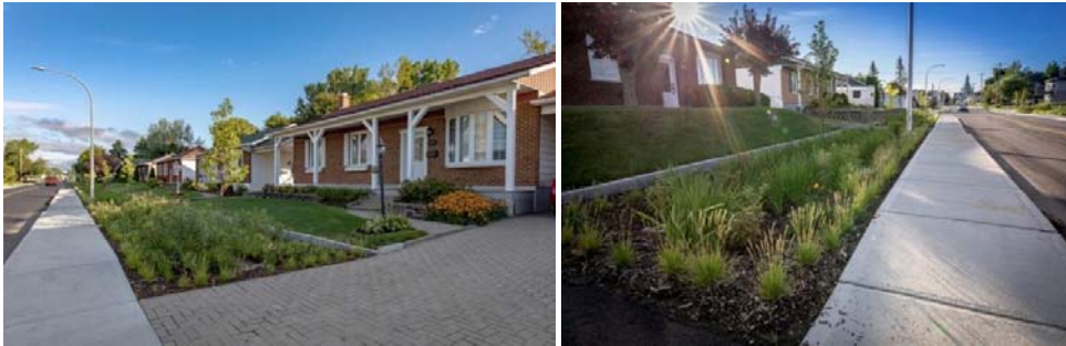
Figure 2 : Deux îlots de biorétentions avec deux mélanges de végétaux différents. À gauche, l'asclépiade est utilisée en fond de bassin alors qu'à droite, l'iris versicolore prédomine.
