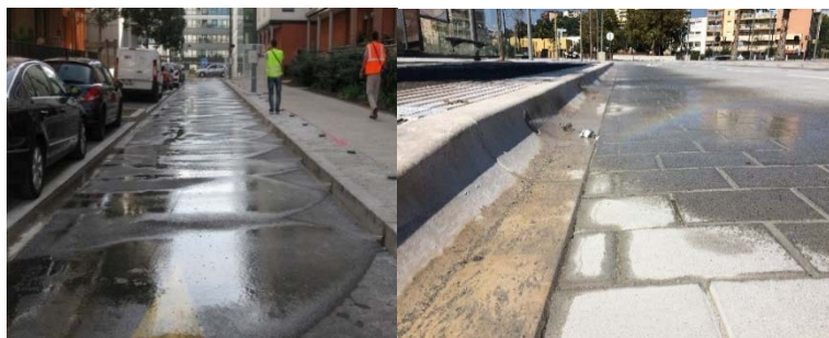
Système d'humidification de chaussées (source : 2EI)
