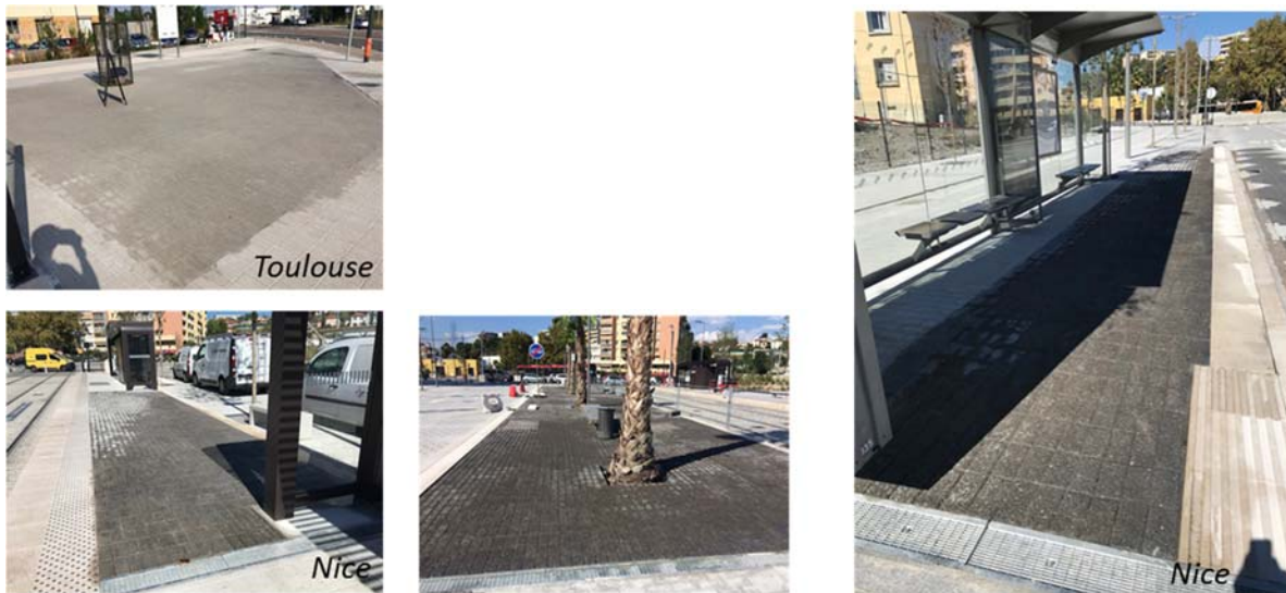
Dispositifs pilote de pavés évaporatifs sur l'espace public à Nice et Toulouse (source :2EI)
