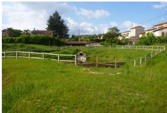
Intégration des différents ouvrages hydrauliques (ouvrage de régulation du débit à gauche, cloisons siphoides habillées et bassin de sédimentation végétalisé à droite)
