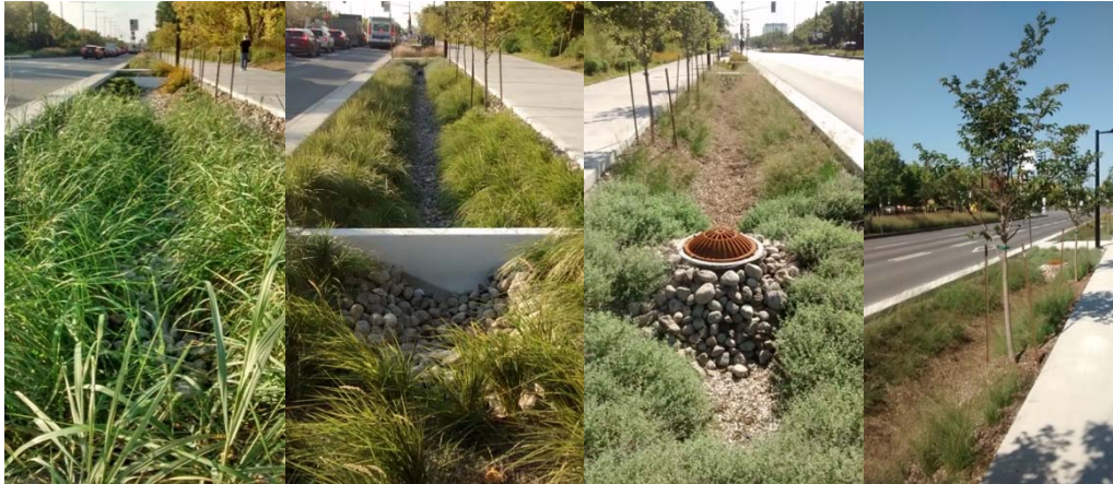
Figure 2 : OGEP aménagés sur l'avenue Papineau à Montréal.
